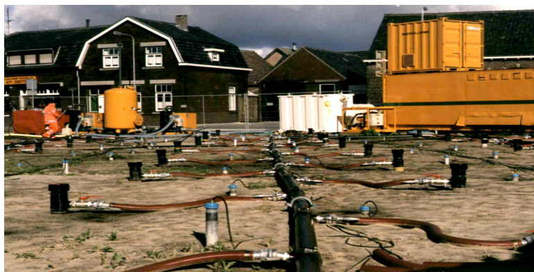
Horst: Elektrobioreclamatie van voormalig olieoverslagbedrijf annex tankstation
